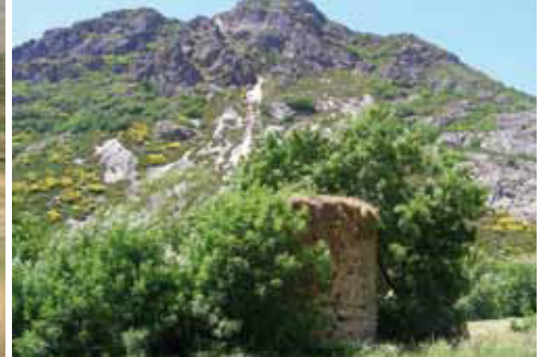
Restos del antiguo torreón medieval de Torre de Babia.
